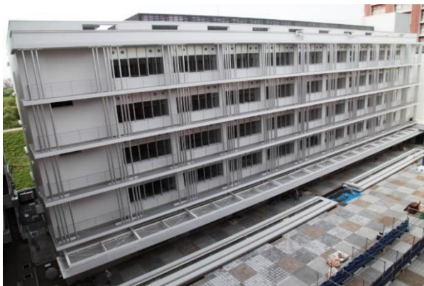
7月31日に竣工する新4号館（7月14日撮影）
